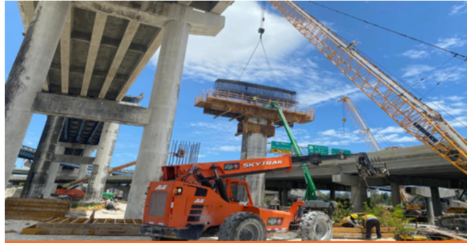
Concrete pour for an SR 836 pier cap
